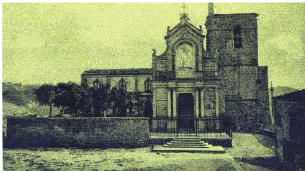
Foto del 1910. L'attuale chiesa di S. Pietro, nella foto, è stata costruita alla fine del 1800.
