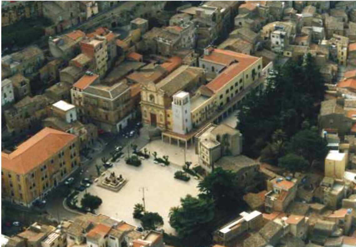
Veduta aerea della Chiesa di Maria SS. del Monte Carmelo.
