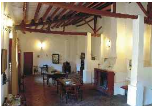
Piazza Armerina, feudo di Friddani. Particolare dell'interno con antiche capriate in legno.
