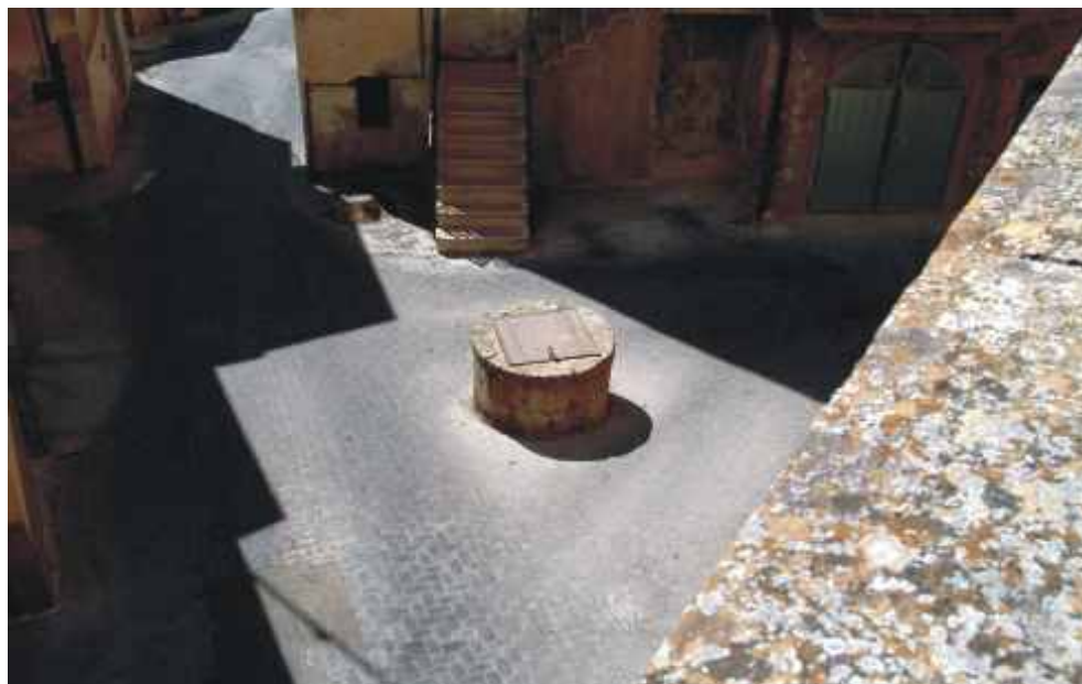
Caratteristica cisterna di Via Soprana, lungo la linea del "quanàt", La vera della cisterna è realizzata con la caratteristica pietra di "cutu" di Calascibetta.
